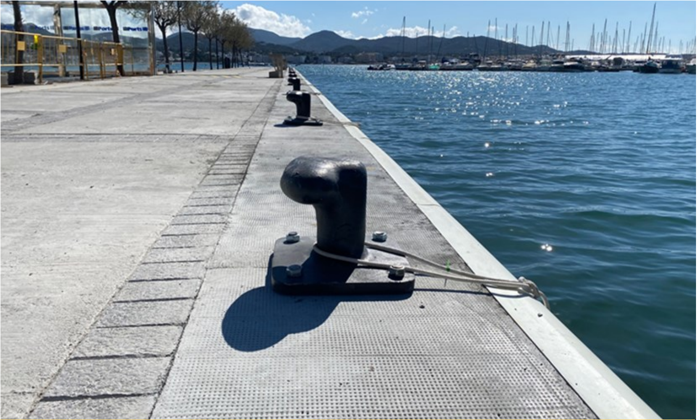
Reparació estructural del cantil del moll d'orenets
