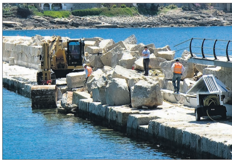
Obres de reparació del dic del Port d'Andratx. / Foto: Txema Oliver-Mallorca Press
